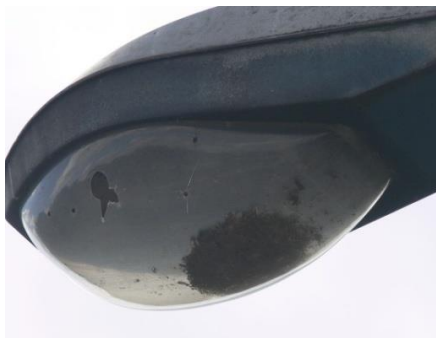
Abb. 6: Insekten gefangen in einer veralteten Leuchte, angezogen vom Licht und durch eine defekte Abdeckung in die Leuchte eingedrungen.
