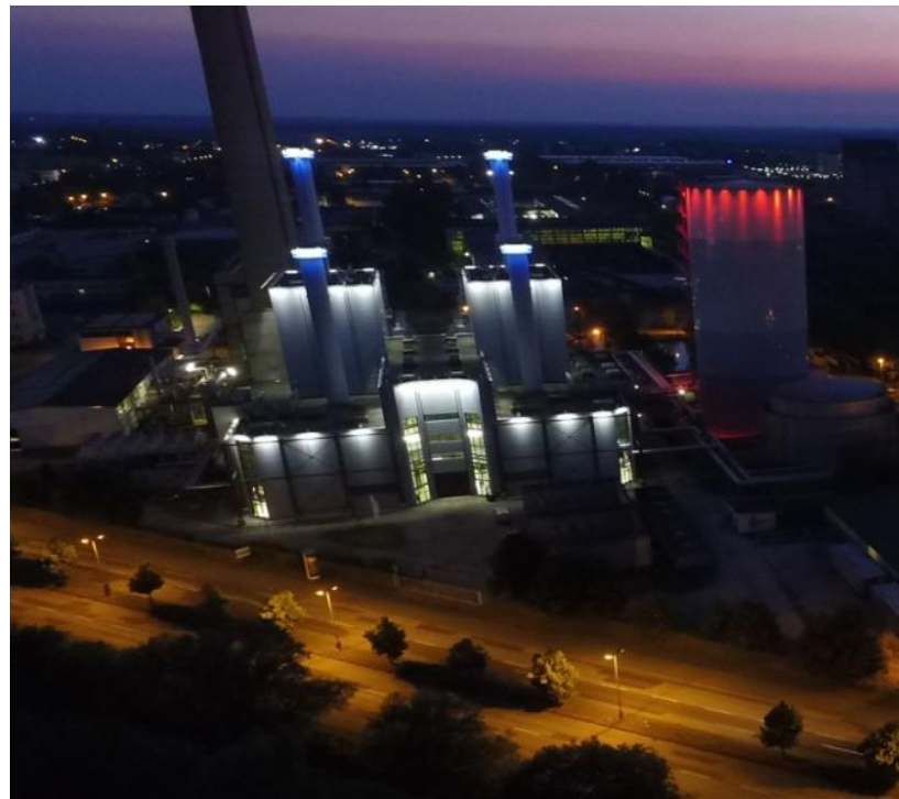
Abb. 44: Gas- und Biogaskraftwerk in Schwerin mit neuer LED Beleuchtung. Die Fassadenleuchten strahlen von oben nach unten, Himmelsaufhellung wird so vermieden. Ein positives Image der Stadtwerke soll durch die emissionsarme Beleuchtung transportiert werden.
