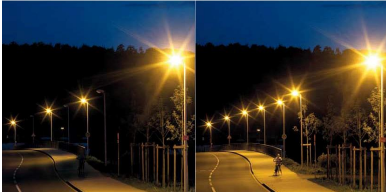
Abb. 34: Tarnzone - Durch das Abschalten jeder zweiten Leuchte entstehen sogenannte Tarnzonen, die eine Unfallgefahr auf den Verkehrswegen, sowie eine Einschränkung der Sicherheit darstellen. Durch das gleichmäßige Herunterregeln aller Leuchten kann das vermieden werden.
